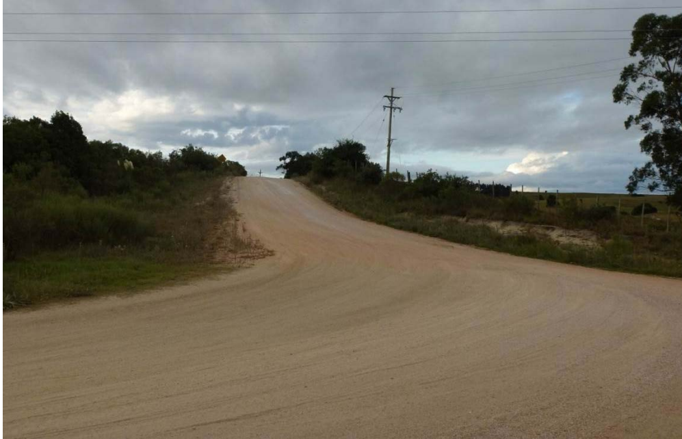
Fig. 47. Ingreso al camino vecinal Este desde Sainz Martínez hacia la Unidad de Actuación
