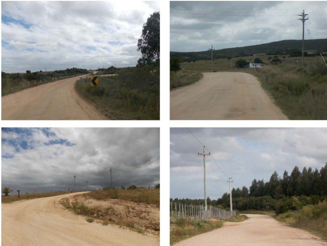
Fig. 26. Arriba: izq.: Cno. Sainz Martínez intersección con camino de acceso este al polígono; der.: camino de acceso este a polígono. Abajo: izq.: Cno. Sainz Martínez intersección con camino acceso oeste a polígono, der.: camino de acceso oeste a polígono.
