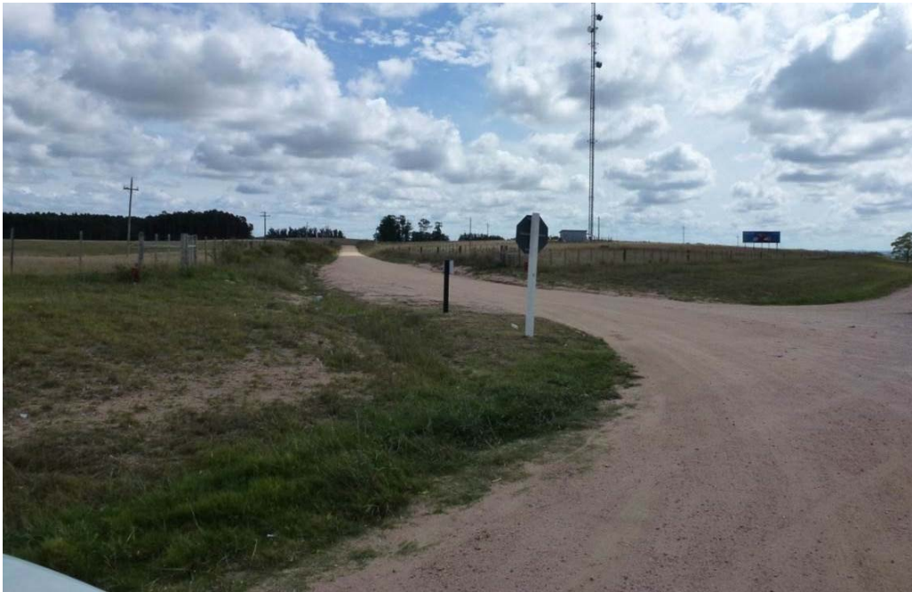
Fig. 38. Entrada por camino vecinal (166k900 de R9)
