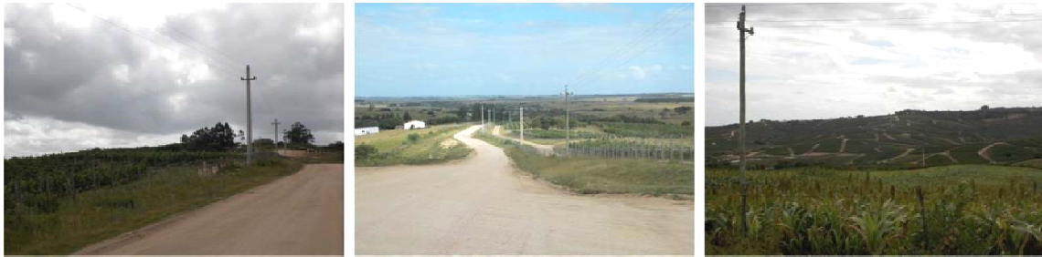
Fig. 29. Tendido eléctrico dentro del ámbito de actuación.
