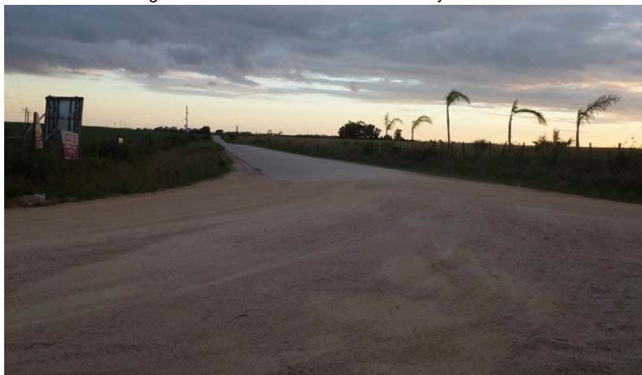
Fig. 43. Inicio del sub-tramo con tratamiento bituminoso superficial
