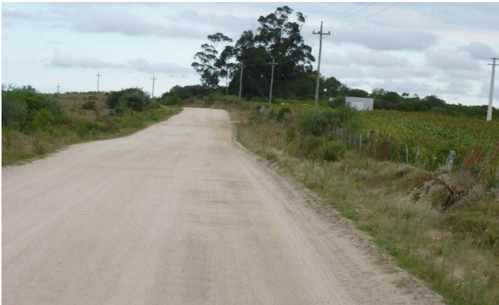
Fig. 48. Conservación aceptable del tramo
