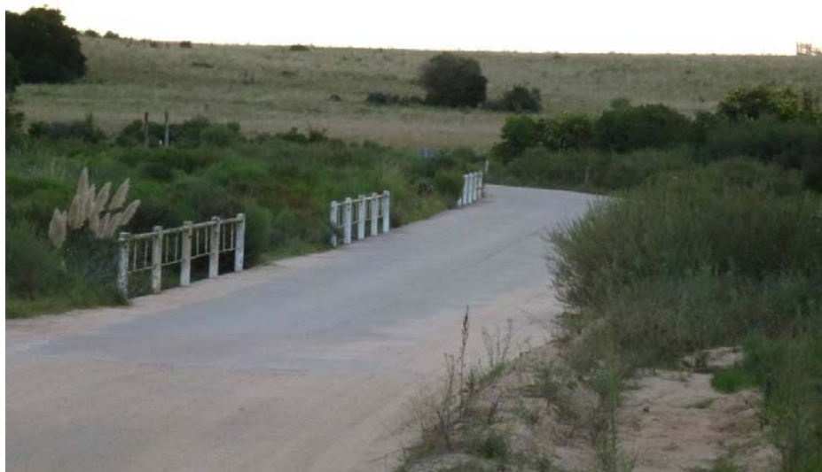
Fig. 42. Obra de arte sobre cañada Zanja de Silva
