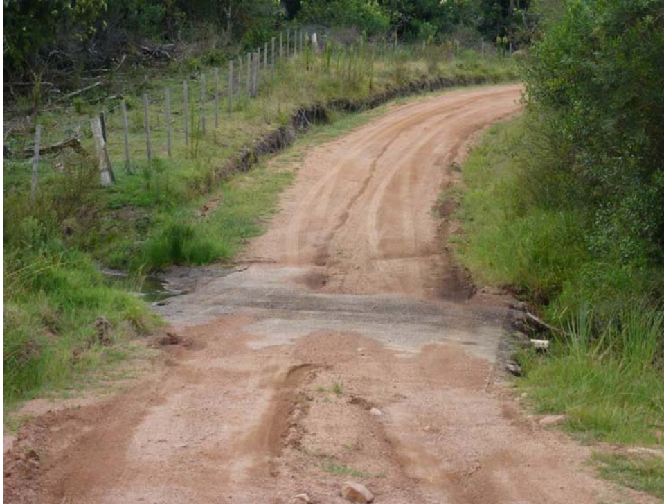
Fig. 51. Pasaje de aguas con obras mínimas
